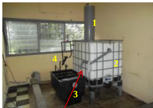
Photo 5 : Circuit fermé (1 ; Biofiltre, 2 ; Bassin collecteur, 3 ; Bassin de décantation, 4 ; Turbe à Ultra-Violet)
